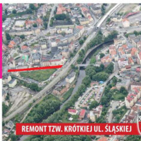
Przebudowa ul. Śląskiej
