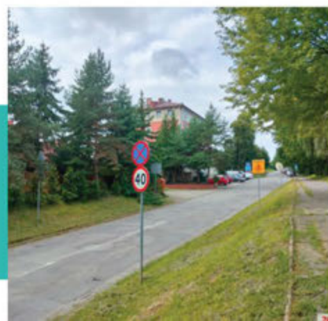
Remont ulicy Łąkowej
