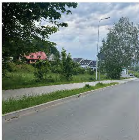
Przebudowa ulicy Lipowej - etap I i II
