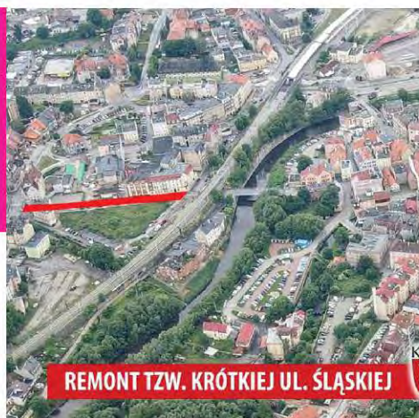
Przebudowa ul. Śląskiej
